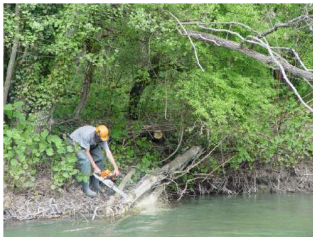
Chantier d'entretien de la ripisylve : suppression des embâcles – rivière les Usses
