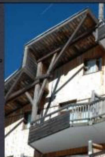
charpente des porte-neige jointifs sur le modèle de l'immeuble Epicea à Avoriaz
